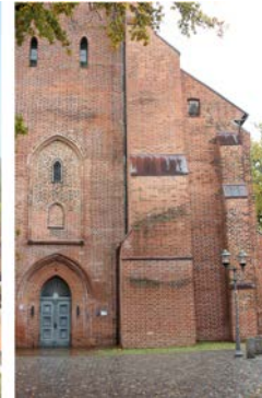
St. Johannis in Dannenberg, Ursprung im 14. Jhd.. Westturm 1458 angebaut. Der ursprünglich polygonale Ostchor stürzte 1812 ein und wurde rechteckig neu aufgebaut. Schäden durch Salzausblühungen (Materialunverträglichkeiten Gips und Zement) vor allem in der Süd-West-Ecke.
