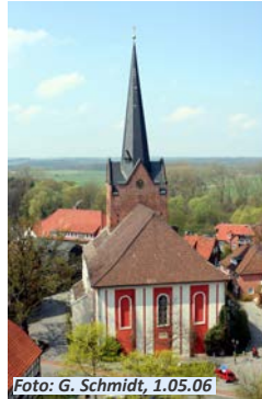
St. Johannis in Dannenberg, Ursprung im 14. Jhd.. Westturm 1458 angebaut. Der ursprünglich polygonale Ostchor stürzte 1812 ein und wurde rechteckig neu aufgebaut. Schäden durch Salzausblühungen (Materialunverträglichkeiten Gips und Zement) vor allem in der Süd-West-Ecke.
