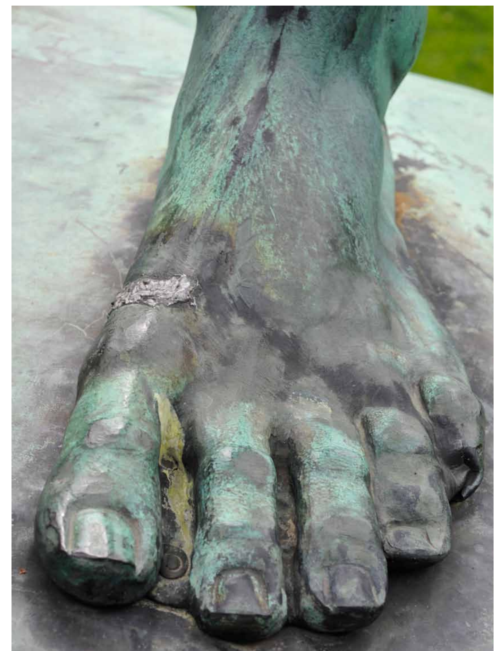
Fuß des Standbeins im Detail mit erkennbaren Altreparaturen
